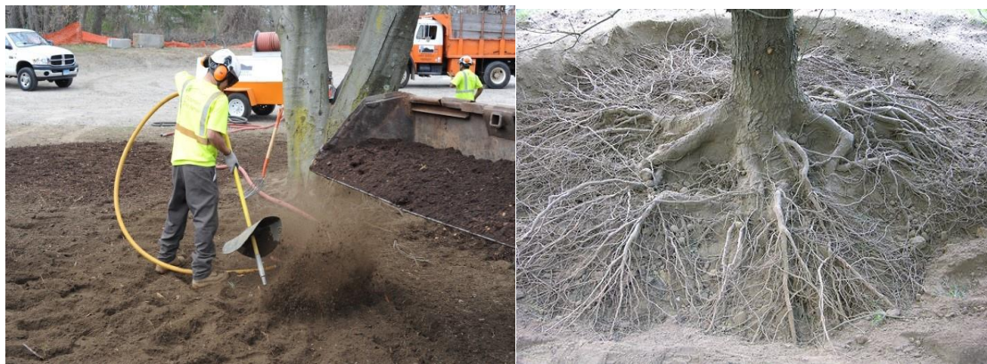
Obr. 21, Obr. 22 Aplikace technologie air spade pro zlepšení stanovištních podmínek dřevin
