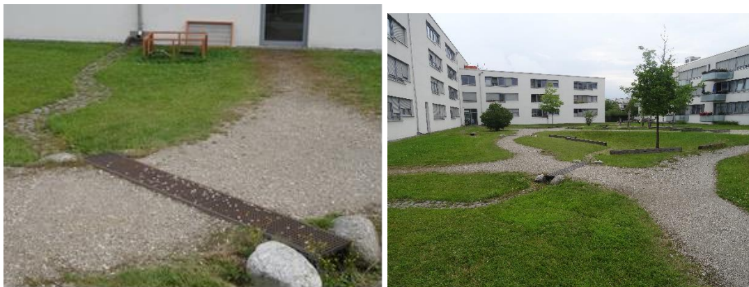
Obr. 29, Obr. 30, Obr. 31 Pojízdnyé povrchy umožňující zasakování vody ve vnitrobloku, Mnichov
