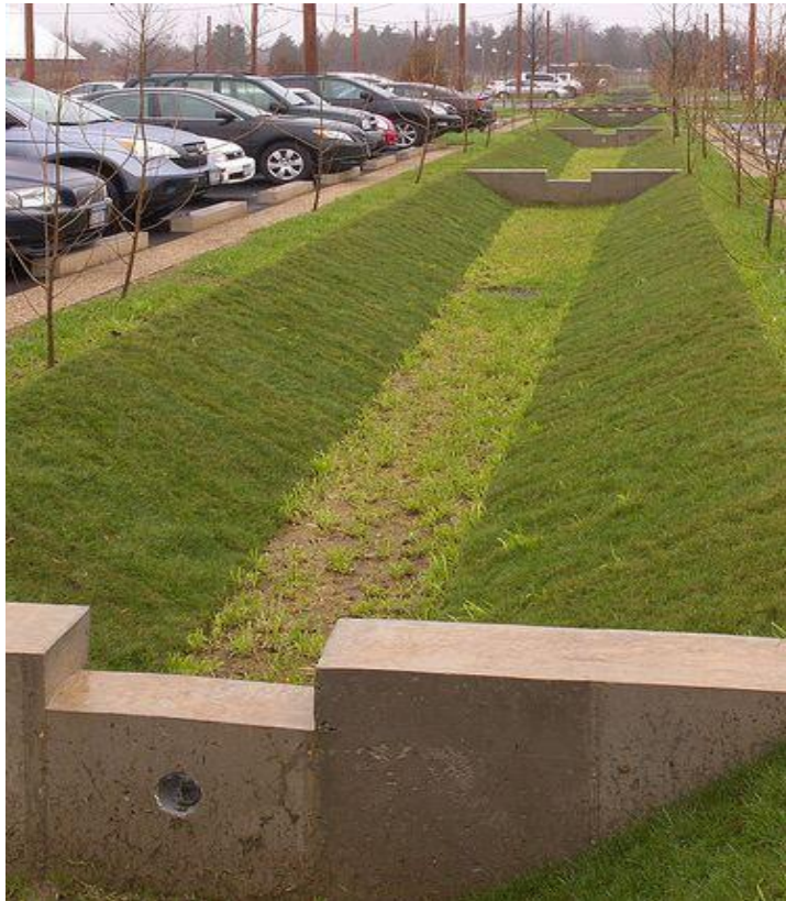
Obr. č. 12 Příklad zasakovacích pásů u parkoviště obchodního domu s vysokým podílem vegetace
