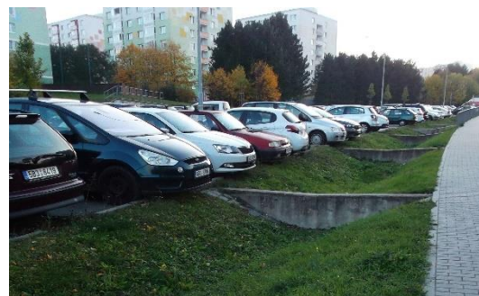
Obr. č. 16 Zasakovací objekty (Brno)
